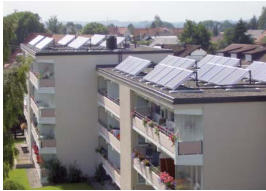
Auf dem Flachdach sind PV-Elemente aufgeständert
